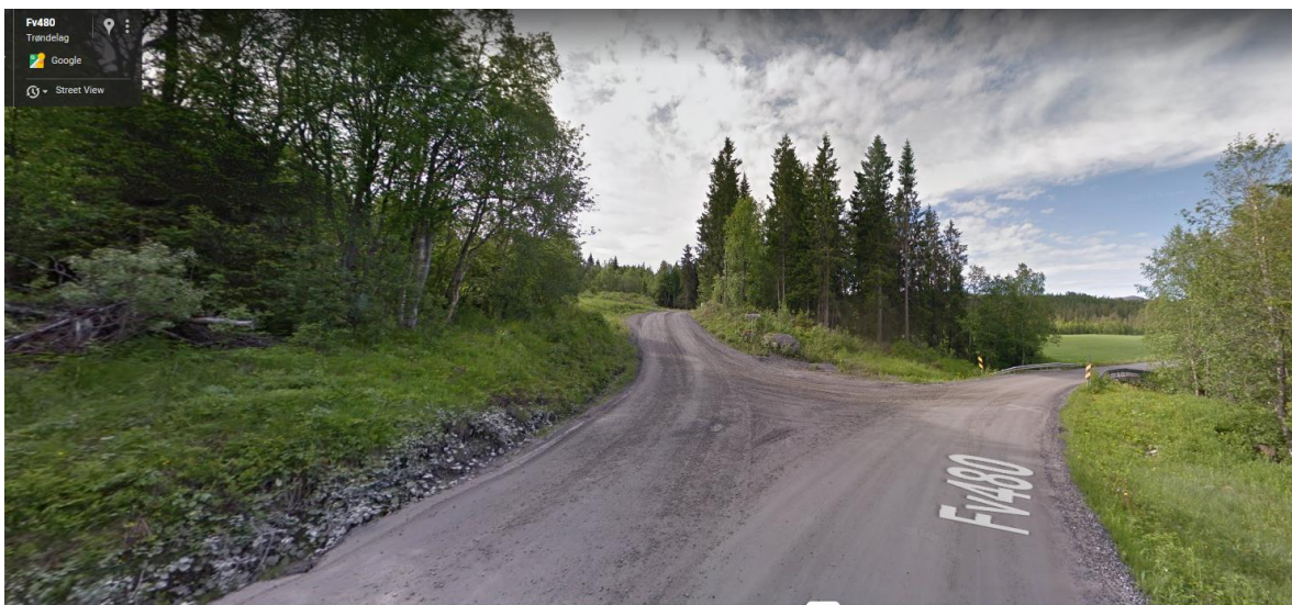
Figur 12. Bilde av eksisterende avkjørsel fra Meåsvegen (Fv 6494)
